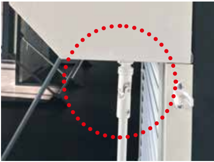
Manivelle de dépannage décroachable
